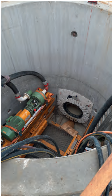
Abb. 4: Startschacht und Stahlbetonrohre DN 600
