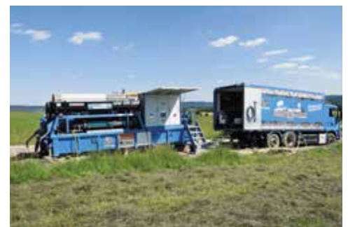
Die mobile und kompakte Anlage ist schnell aufgebaut und dank der vier Hydraulikzylinder in wenigen Minuten in die Waagerechte gebracht und austariert.
